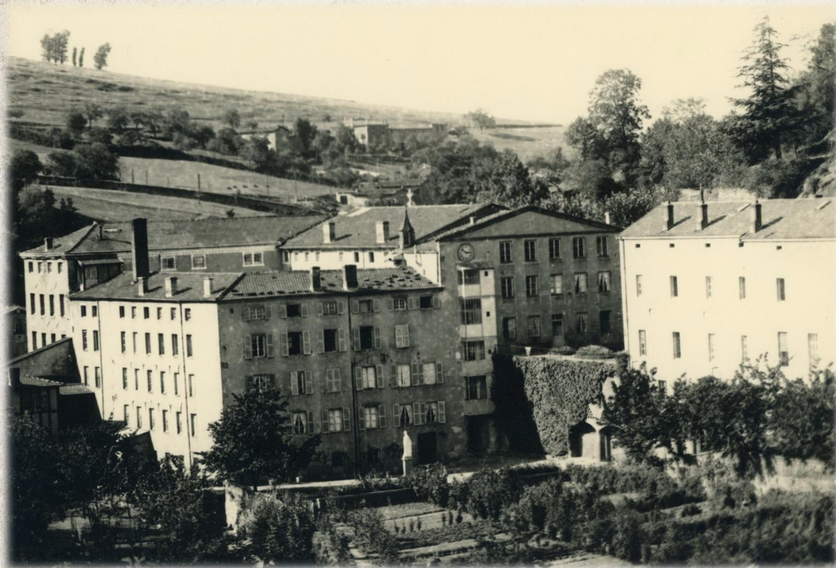
Revitalização da Casa de l'Hermitage
